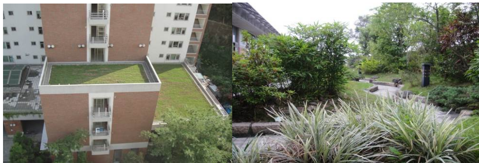
屋頂隔熱系統(左：宿舍大樓、右：設計大樓)
